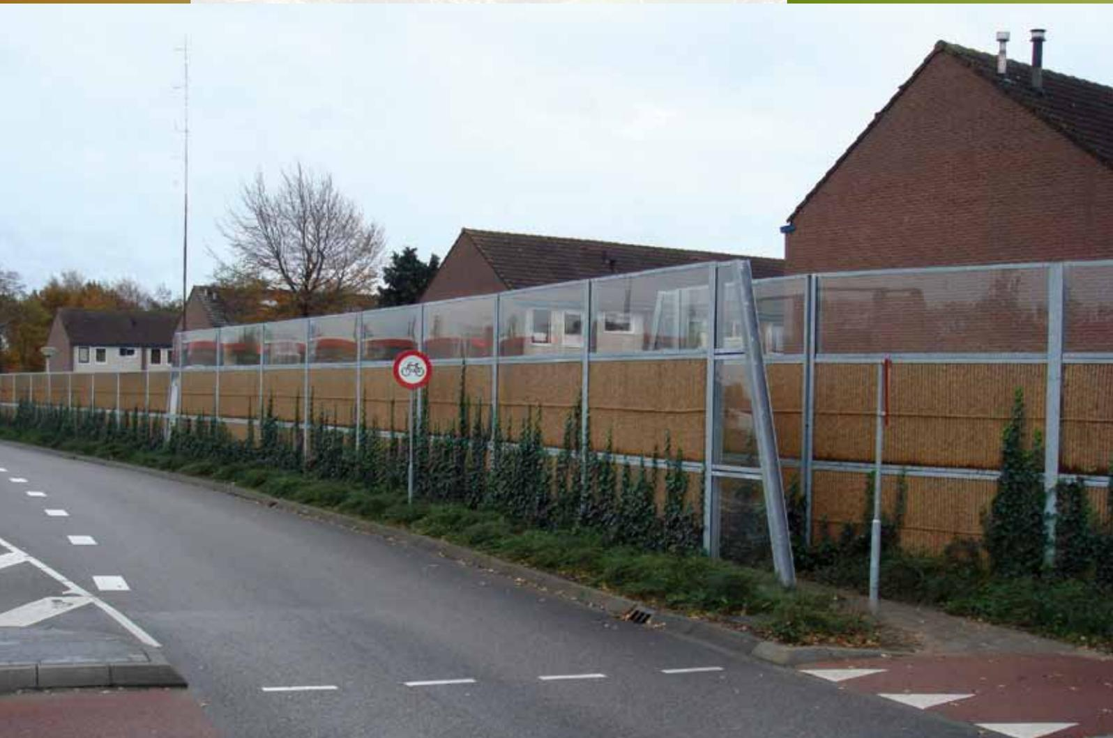
*Un aspect chaleureux et une capacité à s'adapter à chaque paysage, voilà les principales caractéristiques de l'écran antibruit Kokowall®. Kokowall® est un écran antibruit dont l'extérieur est formé de fibres de coco durables pouvant être recouvertes de végétation. En plus de leur importante absorption sonore les fibres de coco constituent un excellent support pour différentes variétés de grimpants. Quelques années suffisent à recouvrir totalement un écran Kokowall® !*
